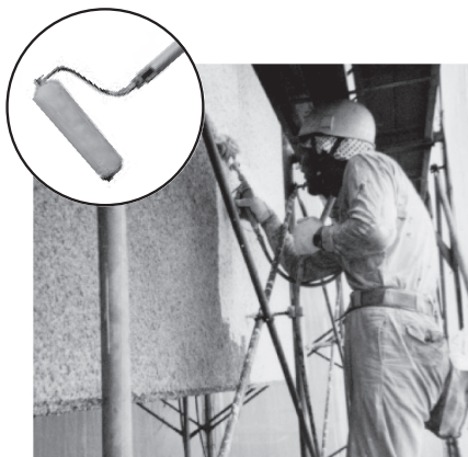
EP・NED塗料の天井・内装施工
